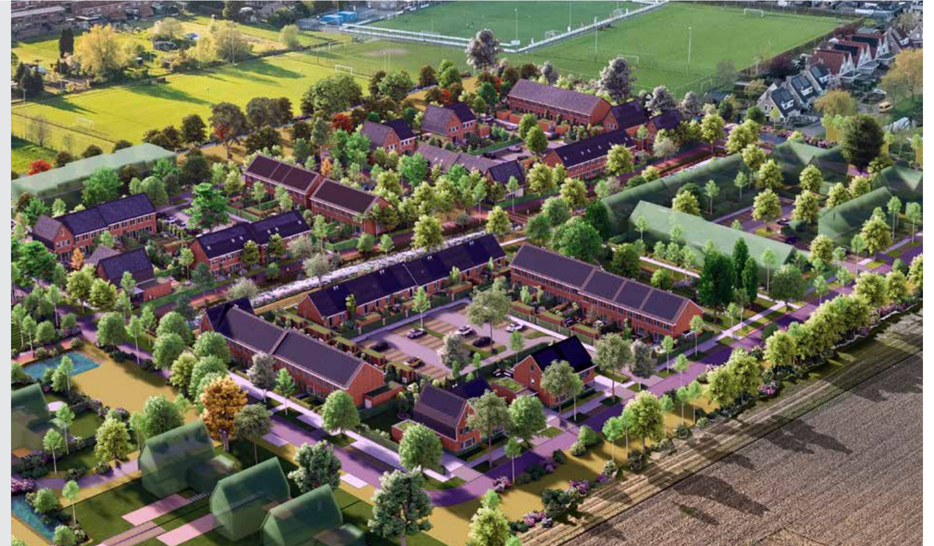
ARCHITECT AAN HET WOORD
